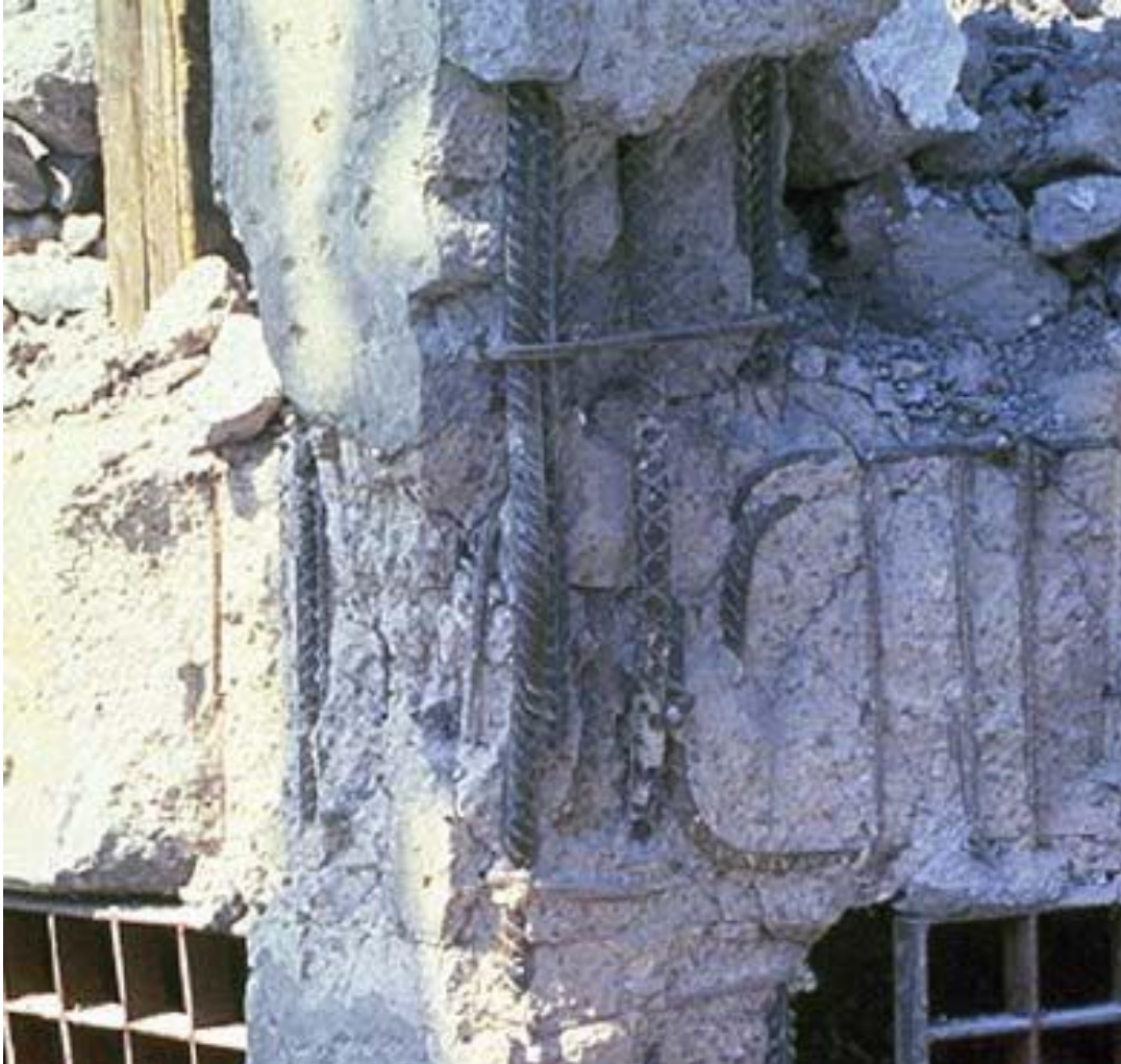
کمانش میلگردهای طولی ستون در ناحیه اتصال چراغ مشهدی سر انبساطی
