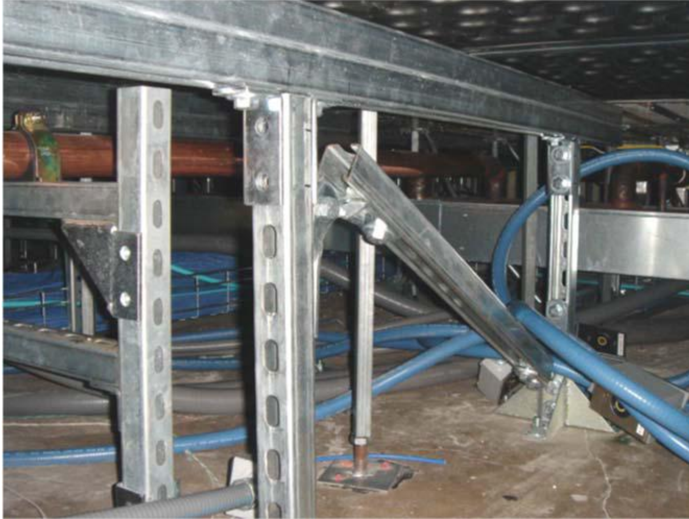
نمونه‌های از نحوه مهار اجزای کف کاذب چوادی مشهدی سراسیابی
